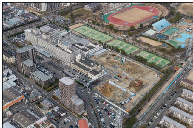
工事現場状況：令和2年1月
